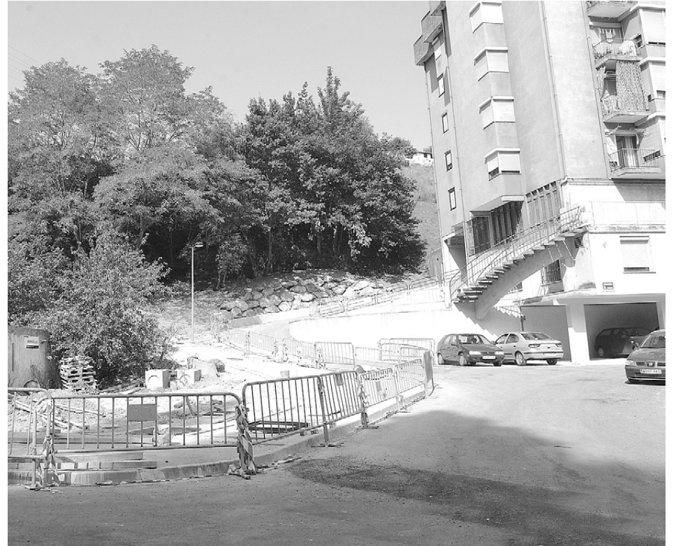
ARRASATE. Makatzena eta Santa Teresa auzoak dira Arrasateko degradatuenetak. Arrasateko Udalak 1.533.343 euro jaso ditu gune horiek hobetzeko. Makatzenen dagoeneko hasi dira konpontze lanekin eta Agerre-Santa Teresa inguruetan 2008. urterako amaitu gura dituzte errehabilitazioak.
