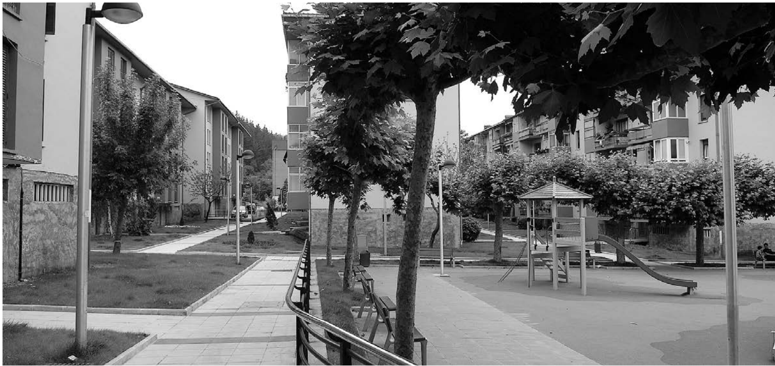
DORLETA Itxura berria du auzoak, baina lur azpiko instalazioak ere hobetu egin dituzte.
