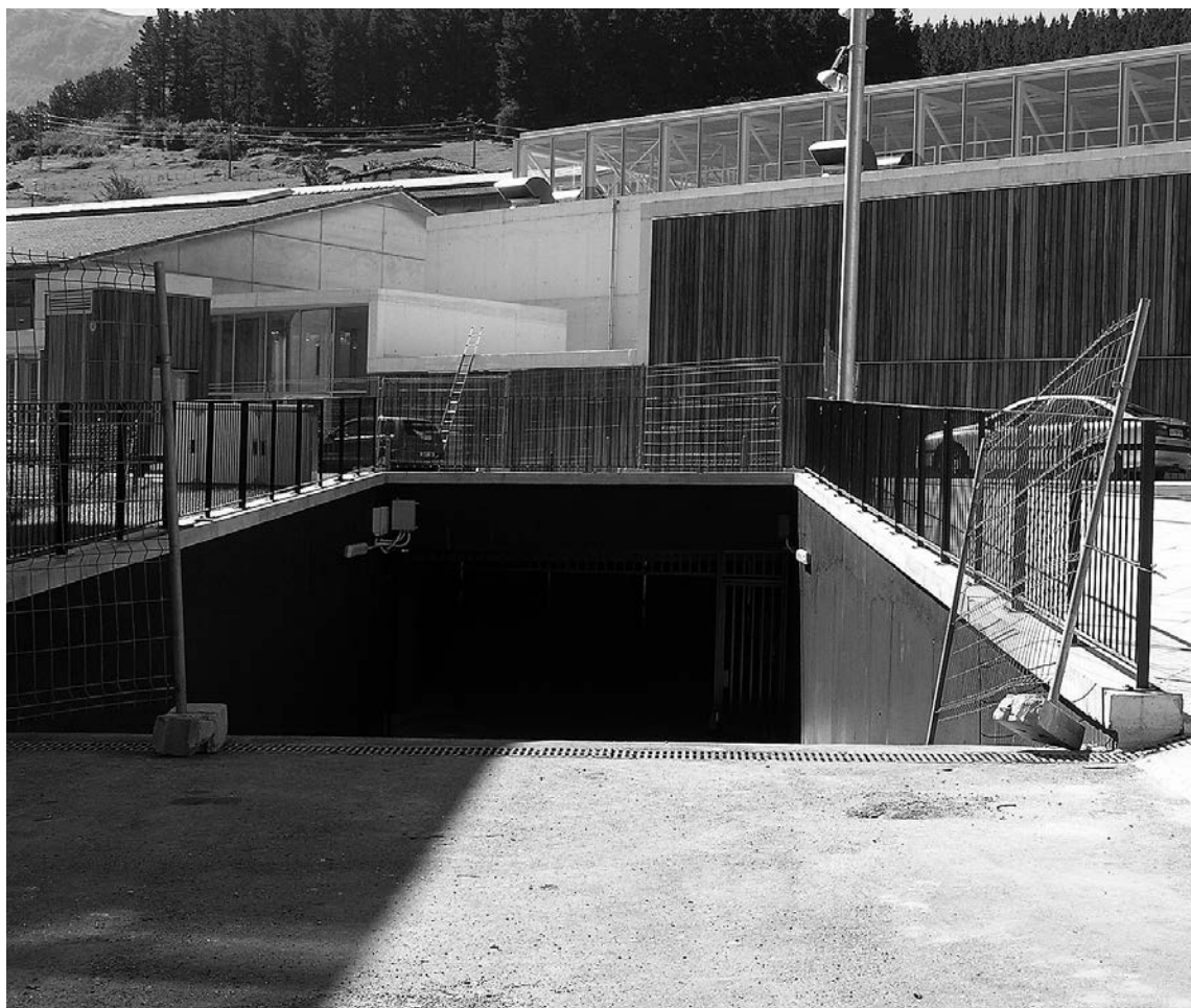
APARKALEKUA Kiroldegi azpiko aparkalekuko sarrera eta irteera leku beretik egingo dira.
