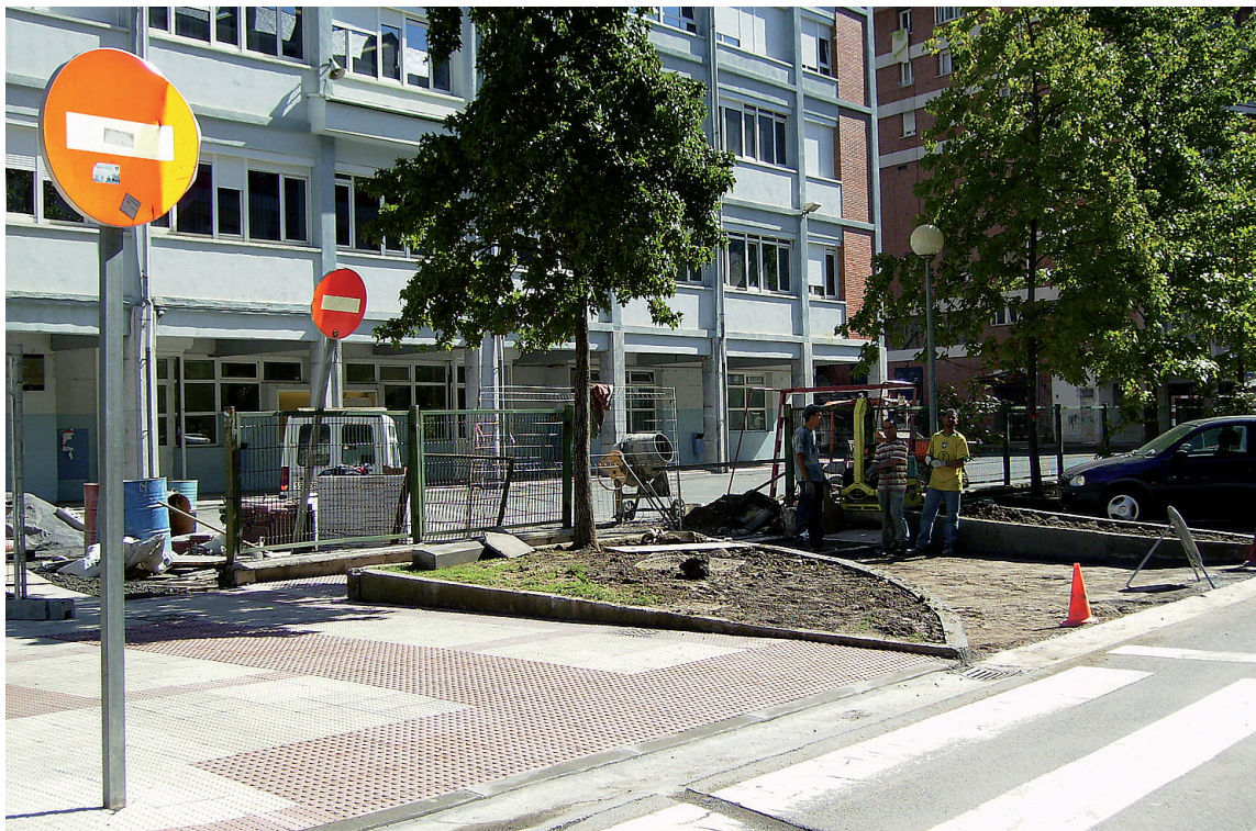
LANEAN Egunotan lurrean baldosak ipintzen ibili dira, orain, zolatzea falta zaie.
