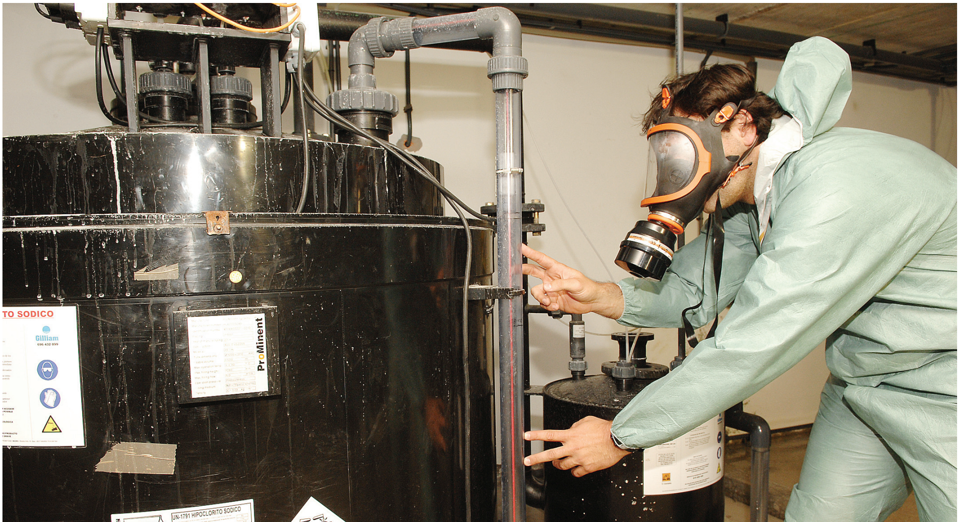
SEGURTASUNA Igerilekutarako Jaurlaritzako Osasun saiaeren araudi berezia dago indarrean. Irudian, Agorrosingo langile bat kloro ihesak kontrolatzeko beharrezko ekipoa frogatzen.
