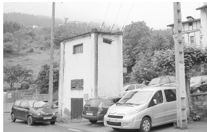
Gatzagan dagoen transformagailua.
