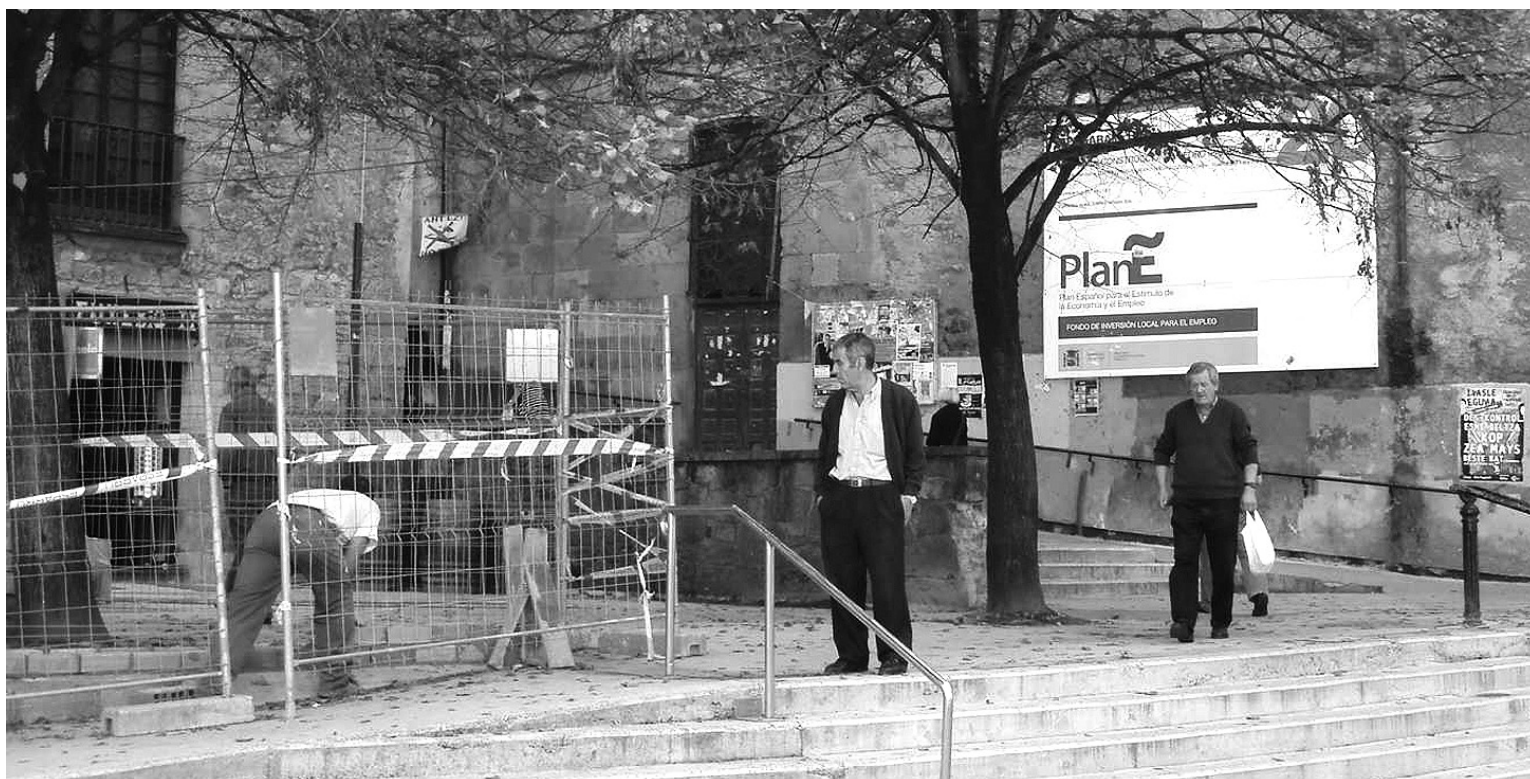
E-Planeko lehenengo txandako obra batzuk, Bergarako Domingo Irala kalean.
