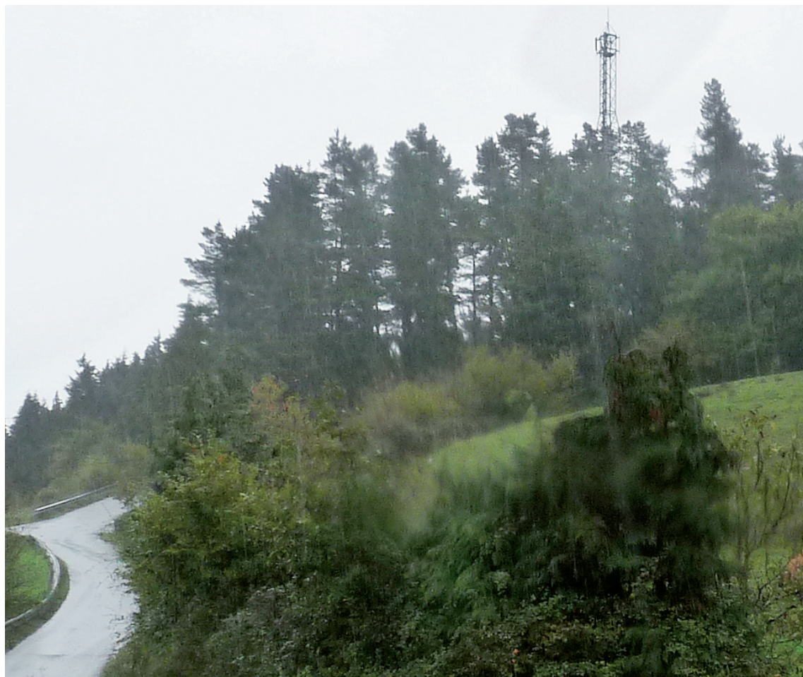
Eskoriatzako hilerriaren inguruan telefonia antena dago.
