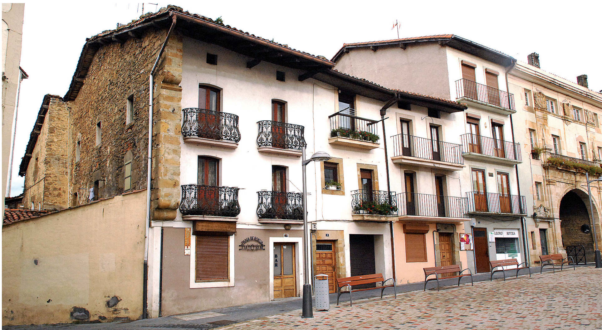
Lehen Panaderokua zegoen eraikina zaharberritzeko lanetan "ahalik eta erraztasun gehien" eman gura die Elgetako Udalak bizilagunei.
