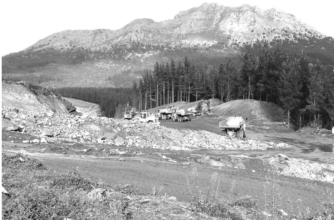
Udalatz azpiko tuneleko eta inguruko ebakialdietako lurak Gesalibarko hondakindegira eramaten dituzte.
