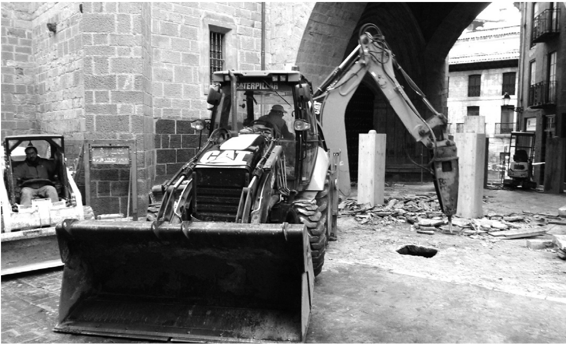
Excavaciones Arrasate enpresa ari da Kanpatorpe kale estrategikoaren urbanizazio lanetan.
