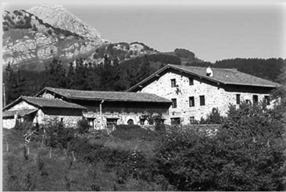
Iturrieta Arraga auzoa / ARAMAIO 945 44 53 85 / 685 72 15 93 iturrietasagardotegia.blogspot.com
