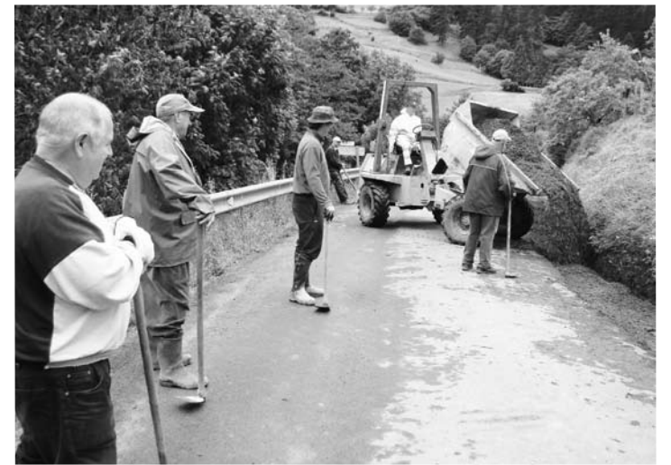
Areak harriez bete zuten zementuz estali baino lehen. | JONE INUNTZIAGA
