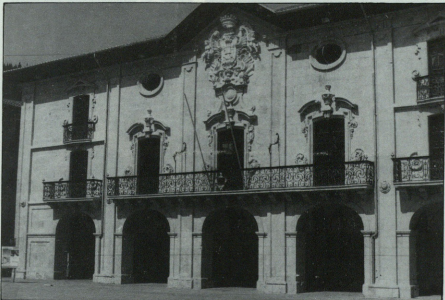
Askoz ere txukunago gelditu da obrak egin eta gero
