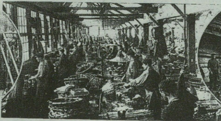
VISTA DE UNO DE LOS TALLERES DE CERRAJERÍA
