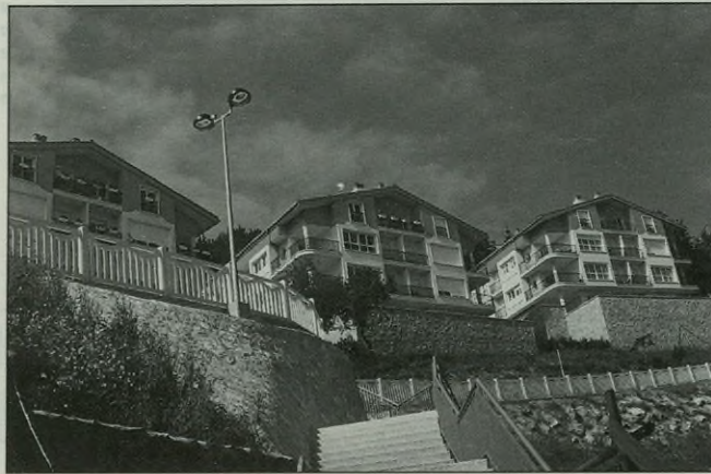
Hamazortzi etxebizitza eraiki ditu Giro-Lekuk Altamirazpin.
