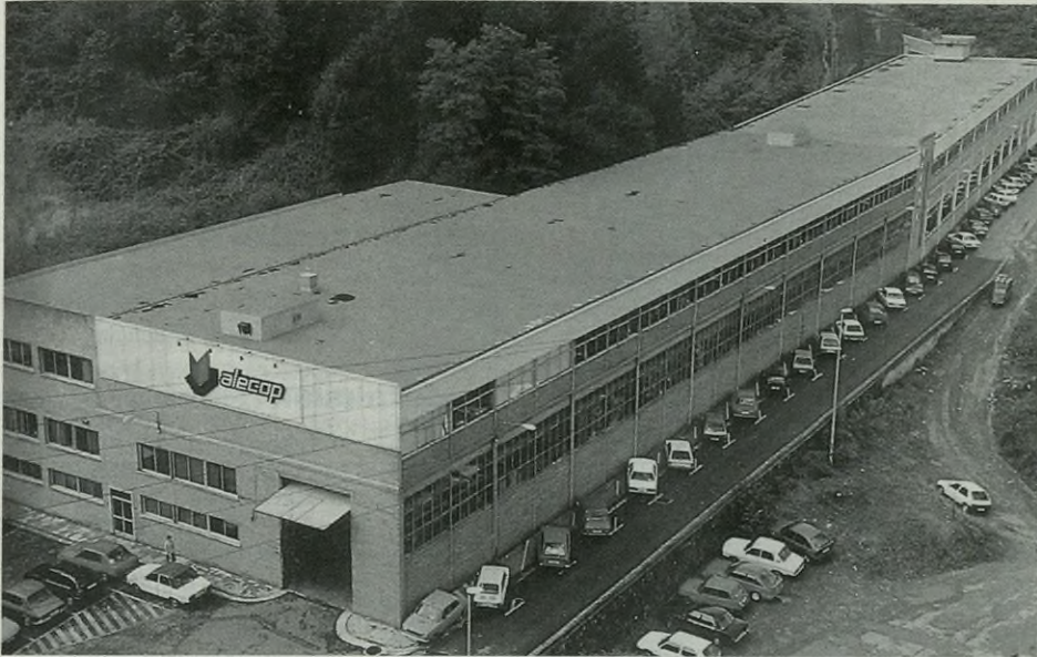
Langile finkoak eta ikasleak biltzen dira Alecopen.
