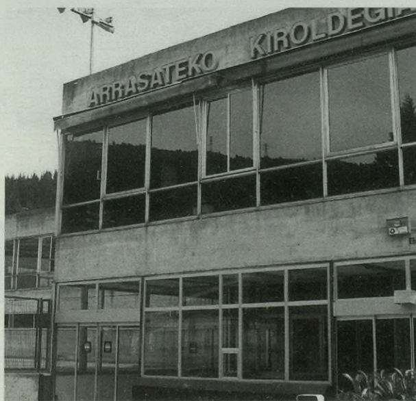
Instalazioak eta pertsonala larrialdi egoetarako prestatuko dira.
