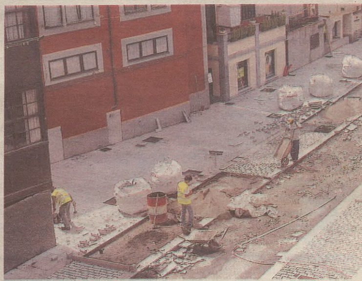
Zoladura lanez gainera, Okendo kaleari dagozkion lanak egitea falta zaie.
