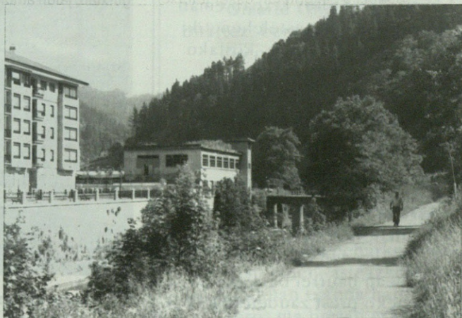
Arau Subsidiarioen arabera Lasagabastereneko lantegi zaharra desagertu egingo da etxeak eraikitzeko.
