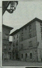
Casa Jaurerri, vista desde el Ayuntamiento.
