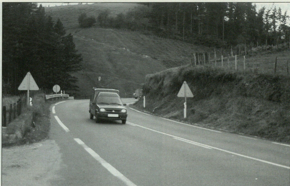
Elorregirik Epelera bitarteko kaminoa ere zabaldu eta konponduko da.
