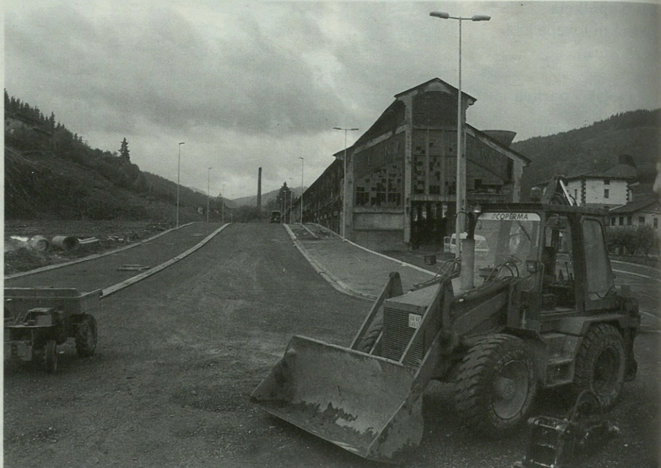
Obrak astiro. Asko kostata izan bada ere, 1998an industrialdeako lehen faseko urbanizazio lanak ia amaitu dituzte.
