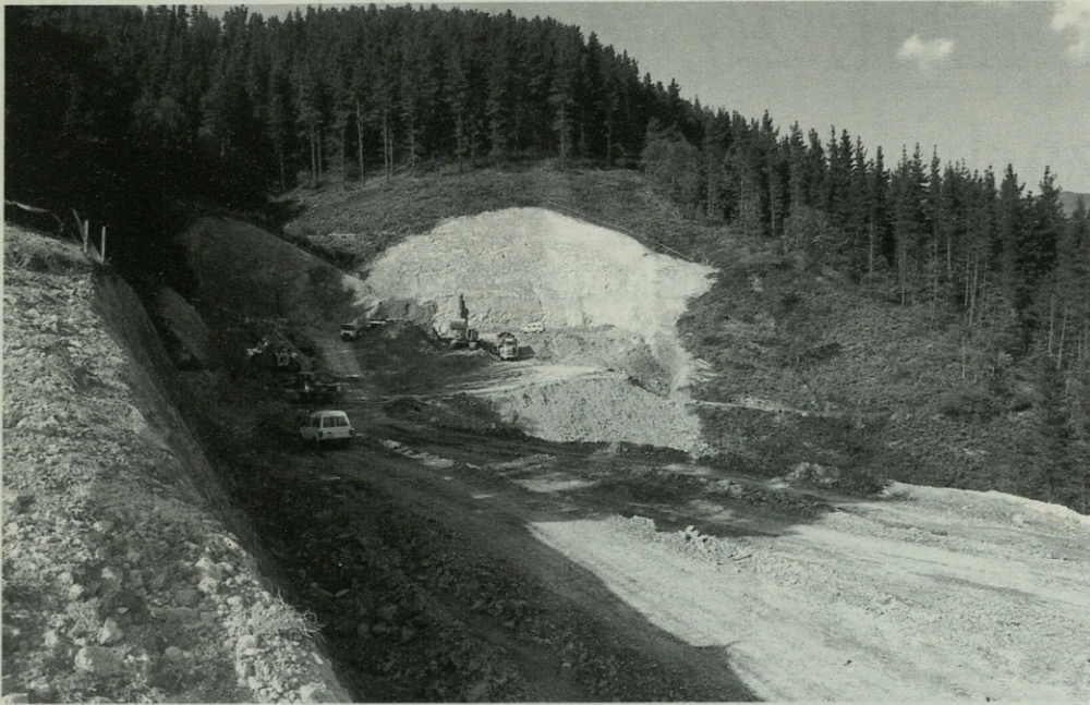
San Antonabat ermita ingurutik Mekolalde arteko lehen tunela, Gallastegikoa, urriaren 15ean hasiko dira zulatzen.
