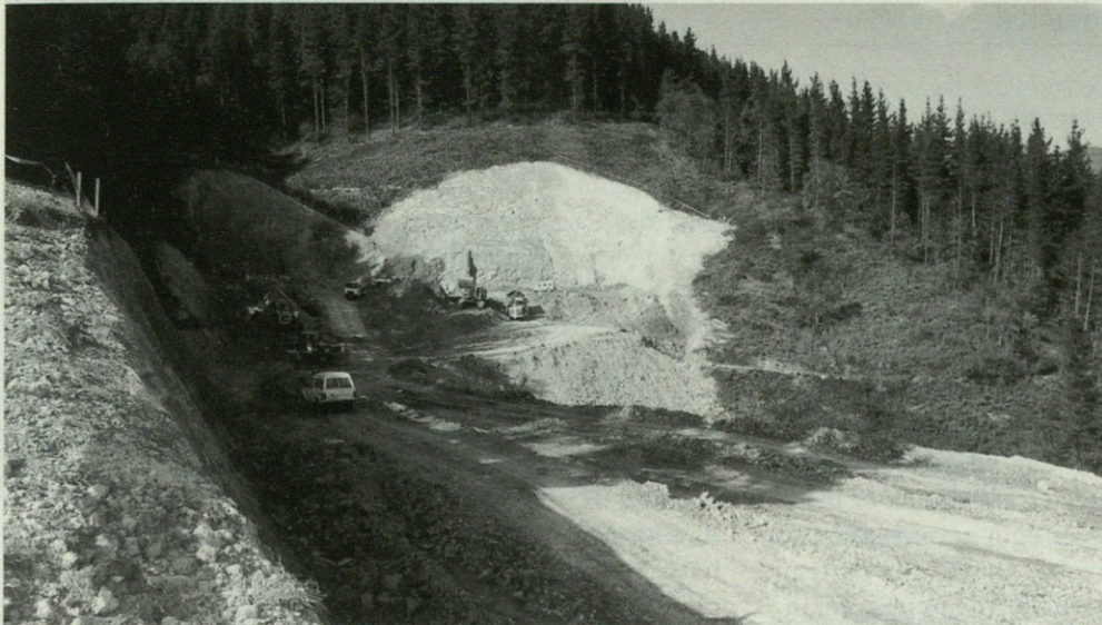
Eibar eta Gasteiz lotuko dituen autopistako lanak dira garraio azpiegitura handien adibide bat.
