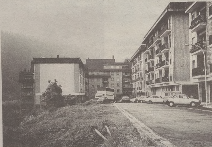
≈ 1991 Artzamendi kalea orain dela 10 bat urteko argazkian. Jaurlaritzak eta Udalak bultzatutako 63 etxebizitza egin zituzten bertan.
