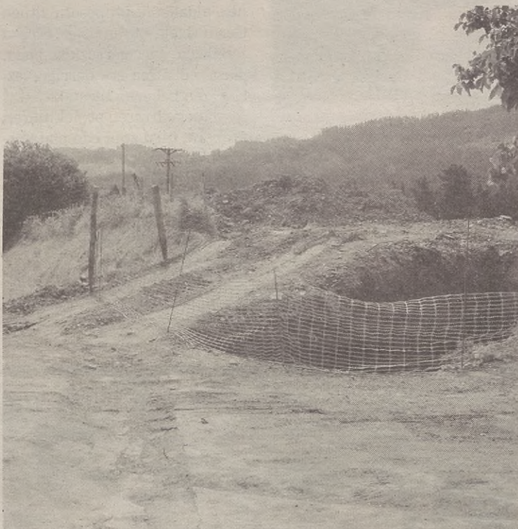
Uriarte auzoan, errepide aldamenean, zulo bat egin dute ur sarea egokitzeko.
