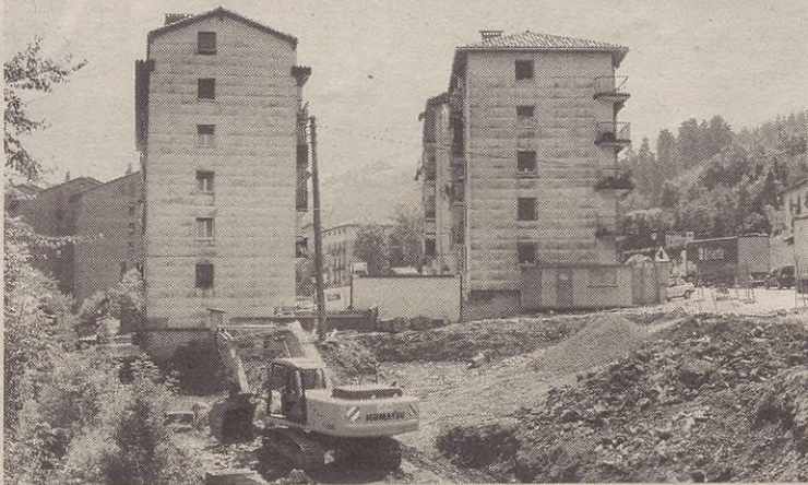
Beheko auzoan hamaika etxebizitza eta Buztinzur in hamalau egingo dituzte.
