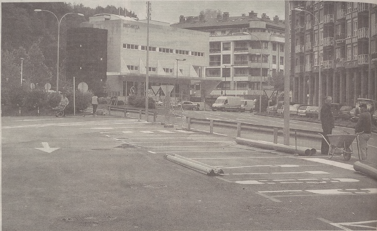
Torrekuan autobus geltokia kokatzeko lanetan dira Obra eta Zerbitzuetako langileak.
