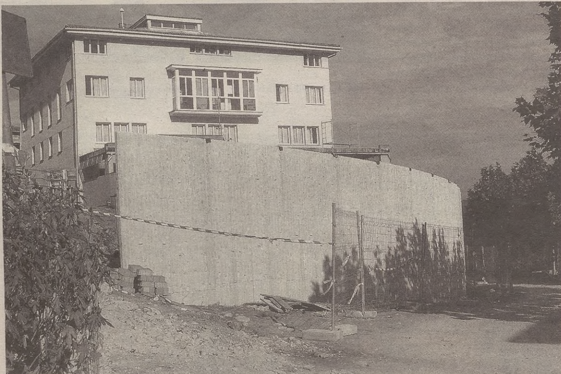
Aurrefabrikatutako horma bat ipini dute Maalako parkean; 4,35 metroko altuera du punturik garaiean.
