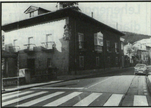
Otalora kaleko fatxadak barrizten hasiko dira.
