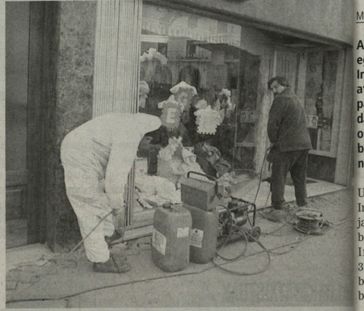
Zuloetan sartutako produktu kimikoak, hesia osatuko du termitak pasa ez daite-
