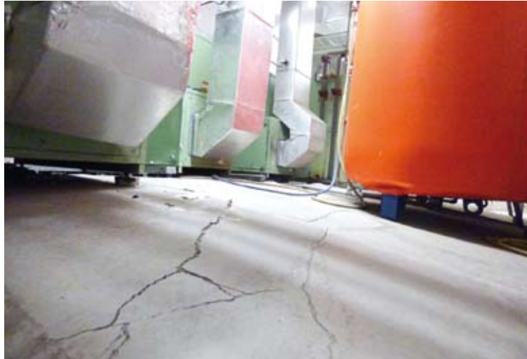
Edonon ikus daitezke pitzadurak makina gelako zoruan. | MIRIAN BITERI
