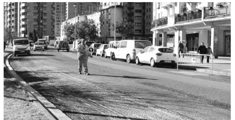
Kontzejino kaleko asfaltatze lanak, martitzenean. | ARRASATEKO UDALA
