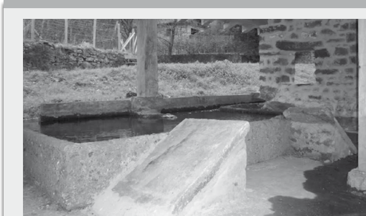
Olabarrieta auzoko labaderoa, auzolanean eraberrituta. | OÑATIKO UDALA
