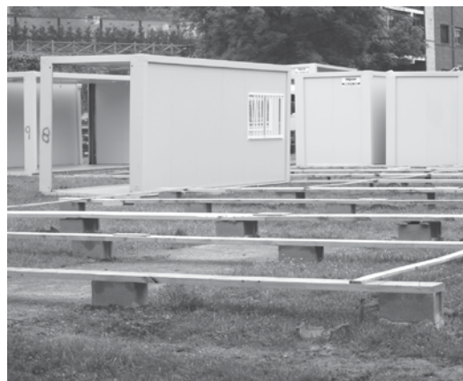
Hasi dira modulu aurrefabrikatuak jartzen. | I.B
