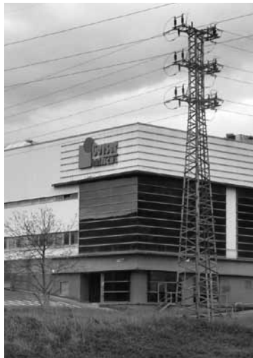
Geyserrena zen lantegia, Bergaran.
