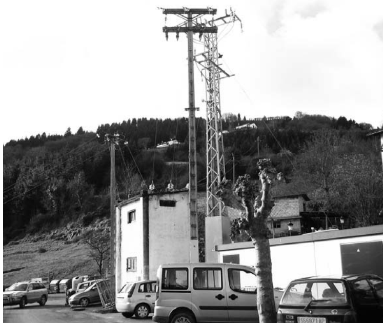
Transformadore berriaren txabola, zaharraren alboan.
