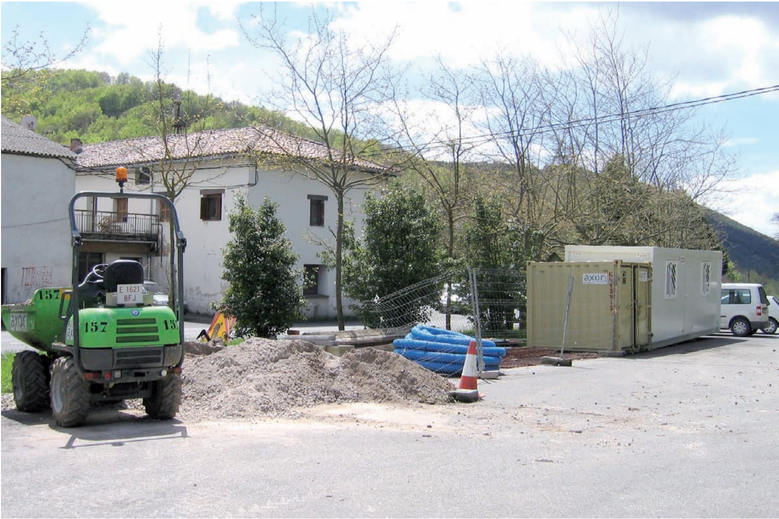
Gatzagainen egiten dabiltzan egokitzapen lanak, ikuspena handitu eta arriskua murrizteko.
