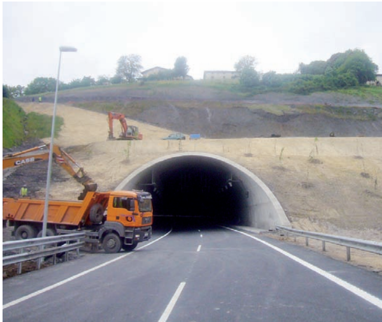
Izurietako tuneleko goiko partea konpontzen dabilta.
