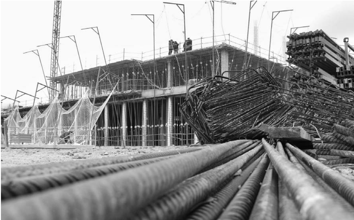
Etxebizitza batzuk eraikitzeako obrak.
