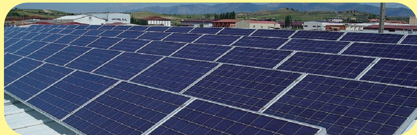
Oiongo metal-aroztegi baten jarritako instalazioa da argazkikoa; 50kW, 228 plaka.
