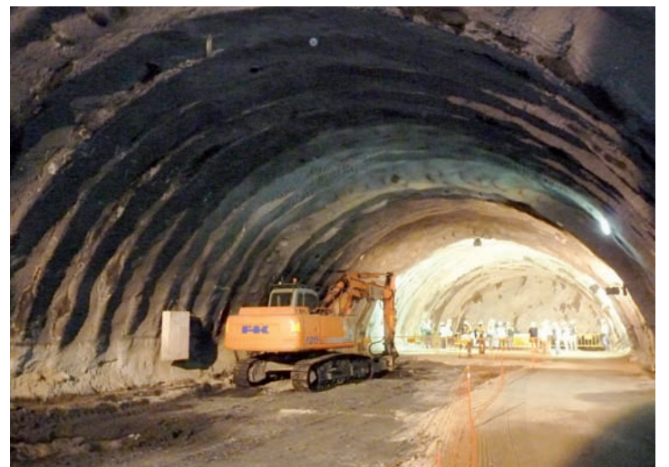
Induspeko tunelak 2.224 metro ditu.
