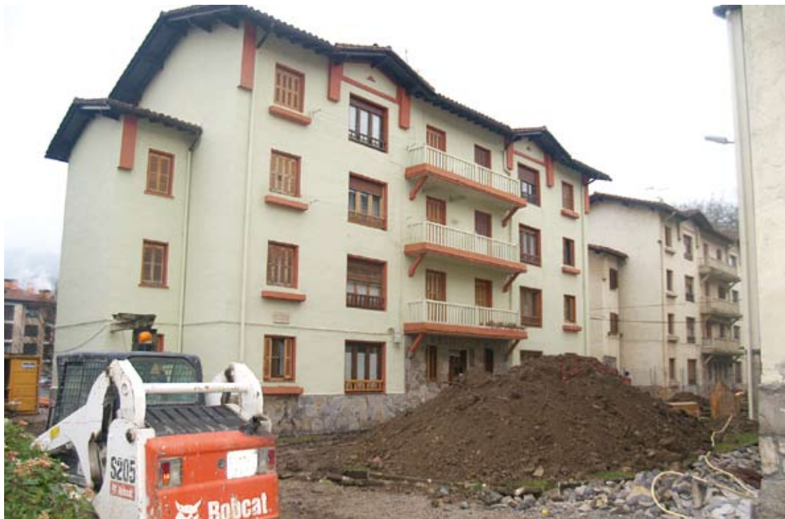
Auzoaren erdia zulatzen eta lurra kentzen dihardute Construcciones Ugarteko langileek. | MIREIA BIKUÑA
