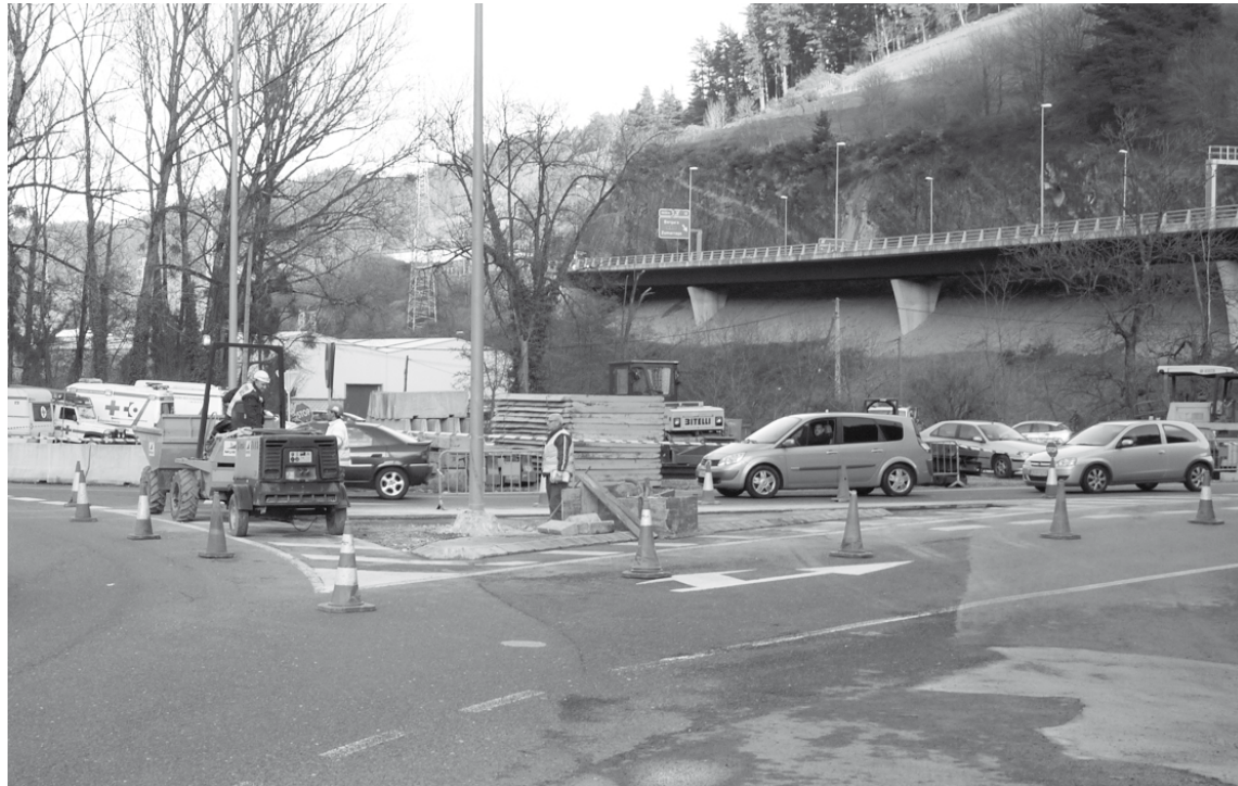
Obra hasteko elementuak ipintzen dihardute asteon Elorregin eta inguruan. | AMAIA GARATE
