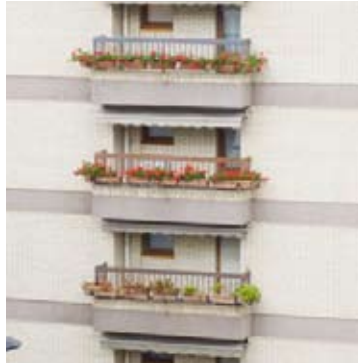
Etxebizitza blokea. | A.B.
