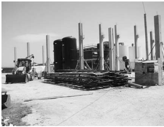
Soriako hiriburutik gertu obretan dagoen instalazioa.
