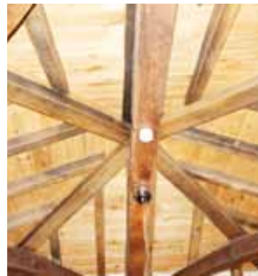
HABEAK Gurutzatutako habe bakarrenetakoak dira. 500 urte pasa dituzte eta egoera oso onean mantendu dira. Egurra mozteko orduan ilargia izaten zuten kontuan.
