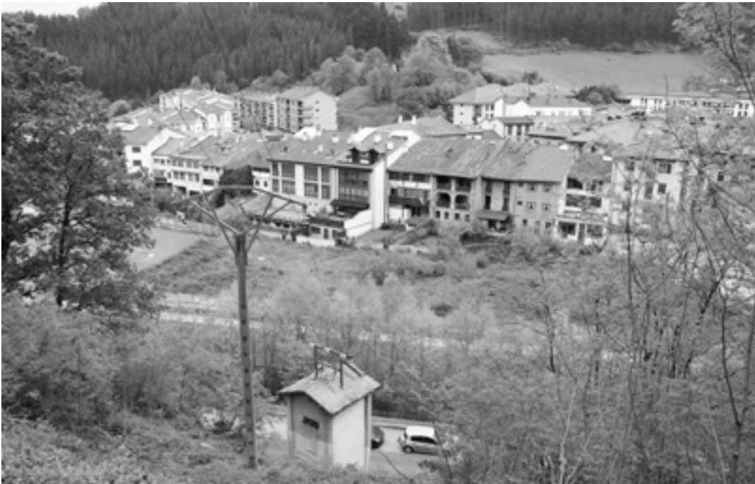
Bidebarrietatik aterata, Santa Ana eta Santa Marina arteko zatian egingo dituzte lanak. IMANOL BELOKI
