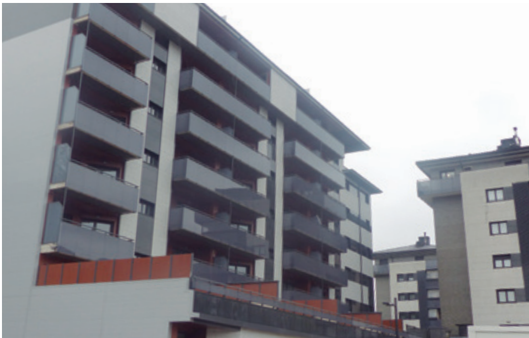
Bergarako Lorentxokoko etxebizitzetako azken blokea amaitzeaz dago. JOKIN ETXEBARRIA
