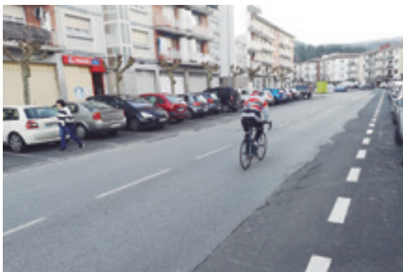
Aretxabaletako Loramendi kalea, asfaltatu aurretik. MIRARI ALTUBE
